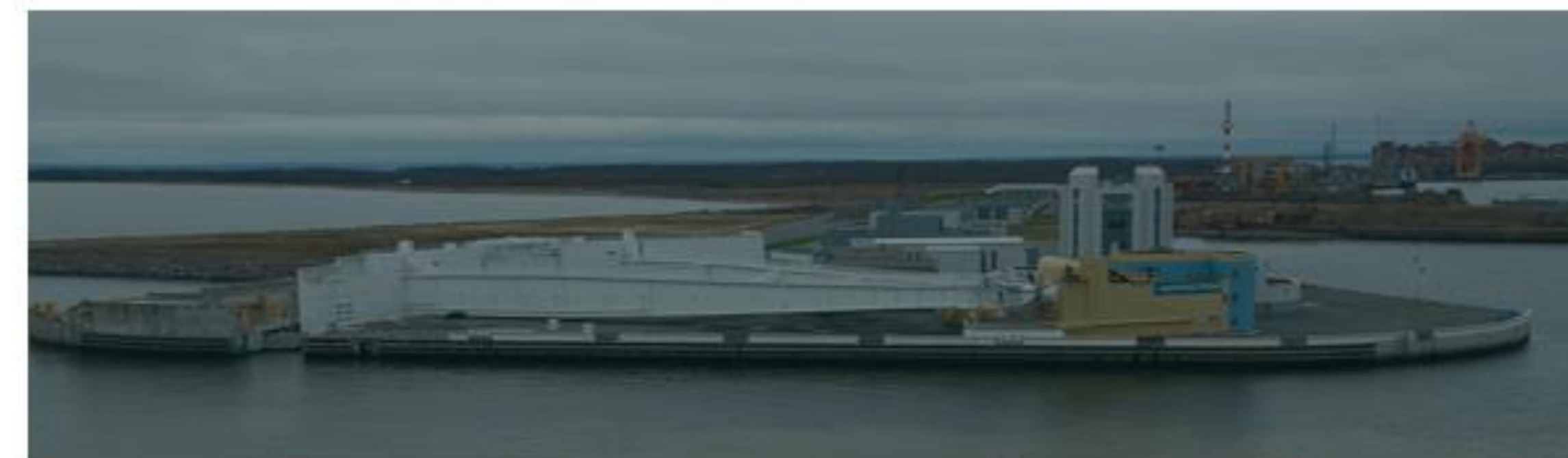
КОМПЛЕКС ЗАЩИТНЫХ СООРУЖЕНИЙ В ФИНСКОМ ЗАЛИВЕ
